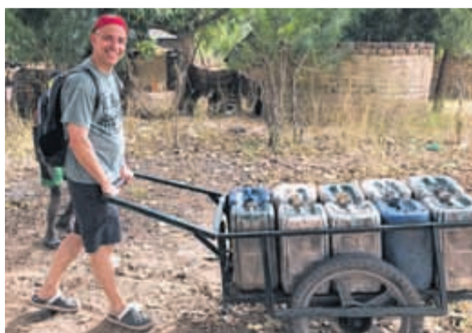
«Ein ganzes Dorf hat plötzlich Wasser», so Felix Bruhin nach dem gelungenen Brunnen-Bauprojekt Bilder ashia.ch
