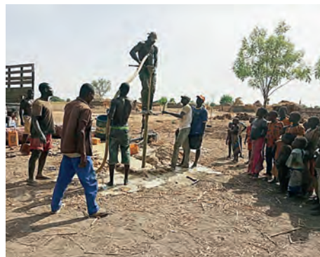
Wo immer möglich wird das Bohrloch von Hand in den Boden gegraben.
