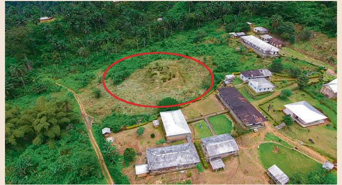
Das Gelände für unseren geplanten Neubau. Davor stehen die momentan verwendeten Bauten des Gesundheitszentrums.
