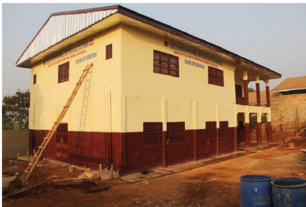
Unser neues Bildungszentrum in Bangang
