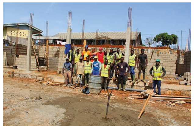
Die Bauarbeiter vor der Baustelle mit Katja und Felix
