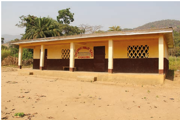
Unser neues Primarschulhaus in Kpongong
