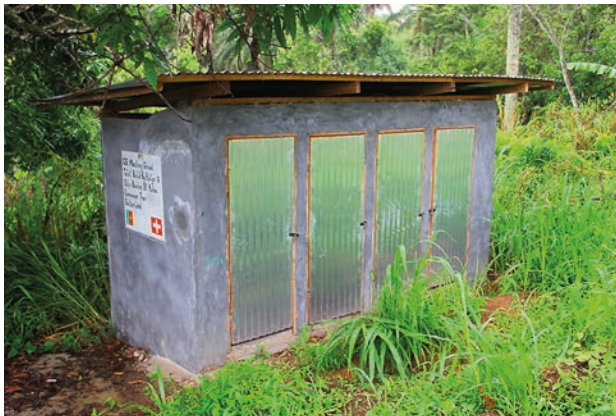
Zwei der 20 neuen Toilettenhäuschen in Bali Nyonga
