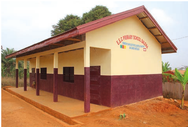
Unser neues Primarschulhaus in Balena
