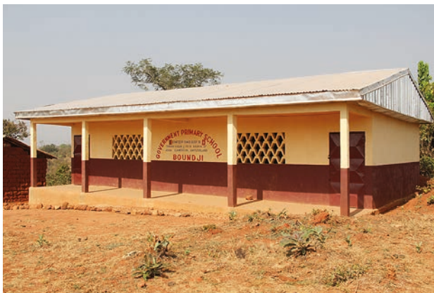
Unser neues Primarschulhaus in Boundji
